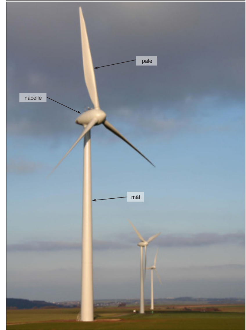
FIGURE 1 : PRINCIPAUX CONSTITUANTS D'UNE ÉOLIENNE
